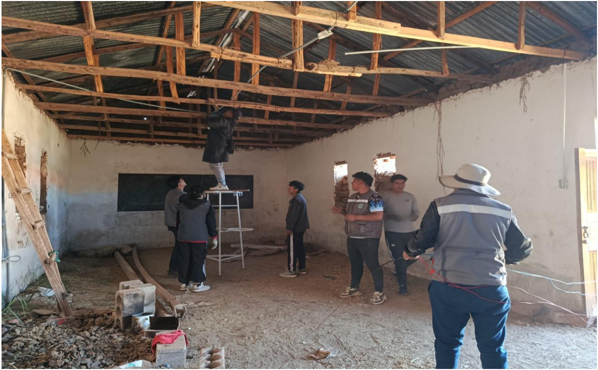
Fotografía de la actividad 2: Instalación eléctrica en el salón 1
