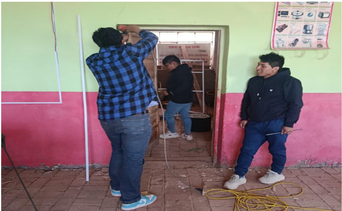
Fotografía de la actividad 3: Instalación eléctrica en el salón 2
