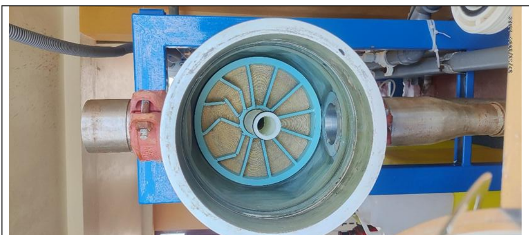
Módulos de ósmosis inversa – Vista de las cuatro membranas conectadas en serie, actualmente saturadas y programadas para reemplazo anual,
