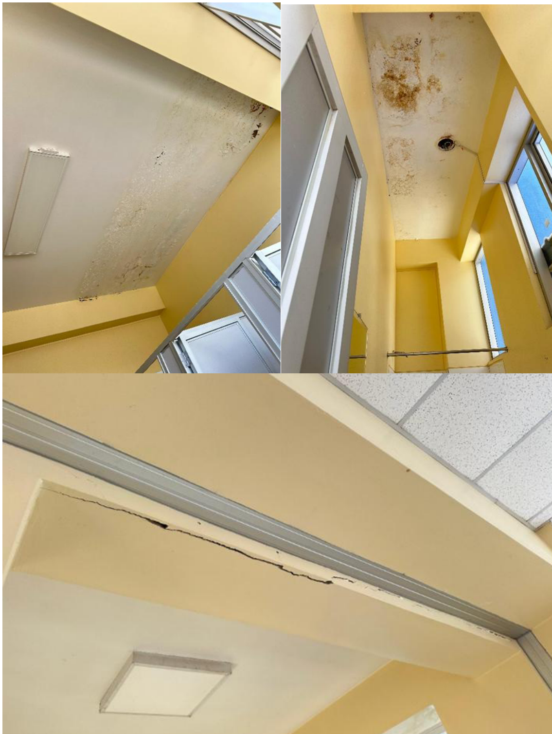
Figura 6 Estado de actual y techos
