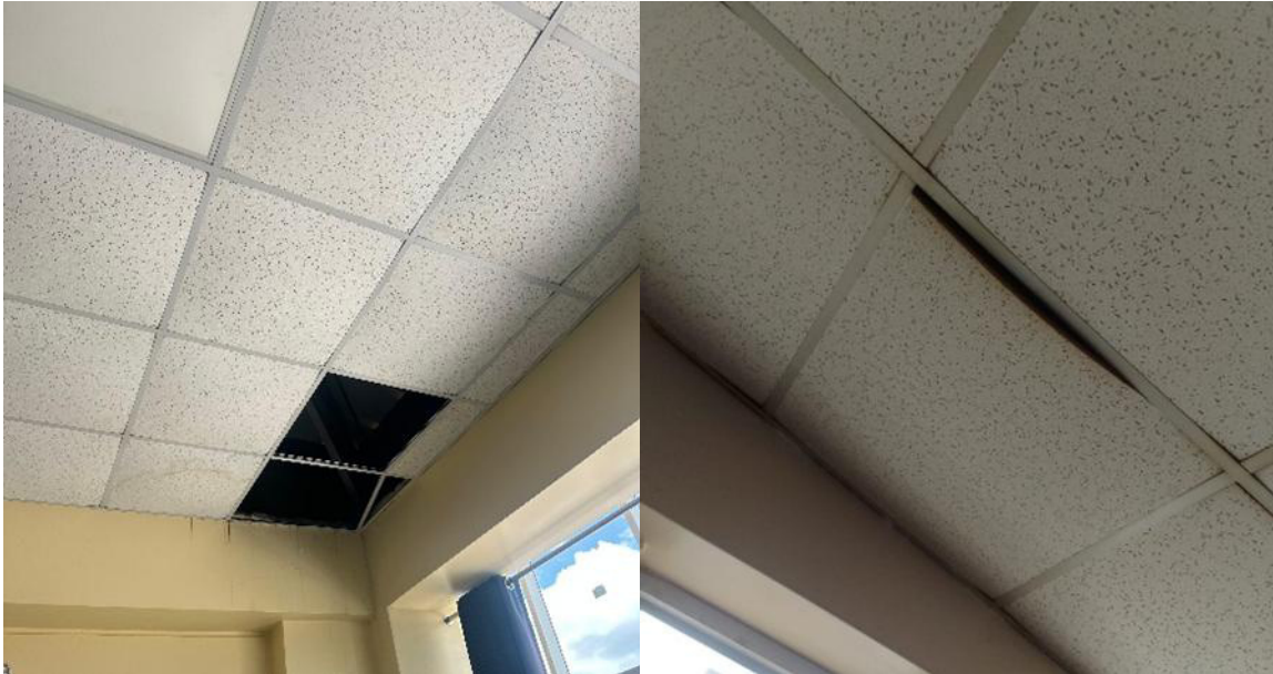
Figura 8 Cielo raso existente
