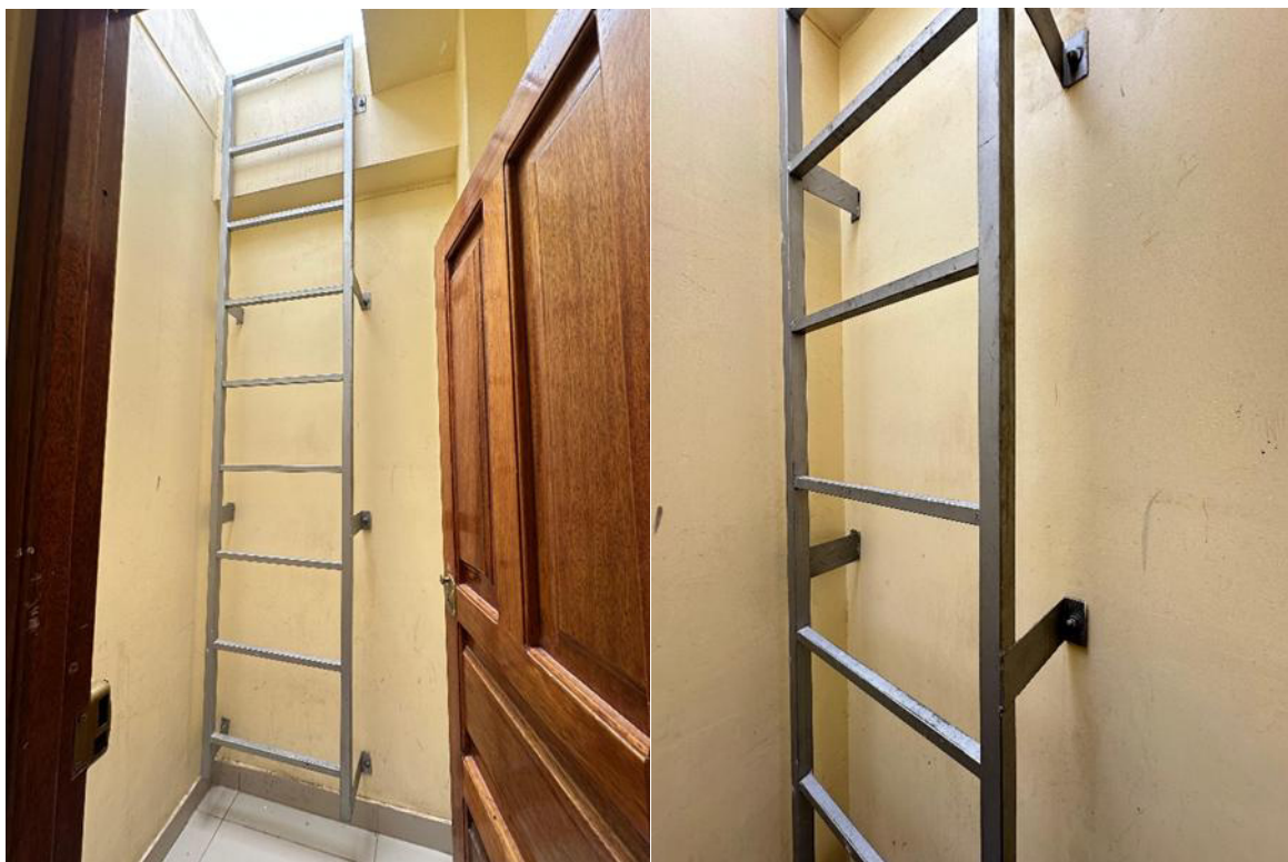
Figura 17 Fotografías de la escalera
