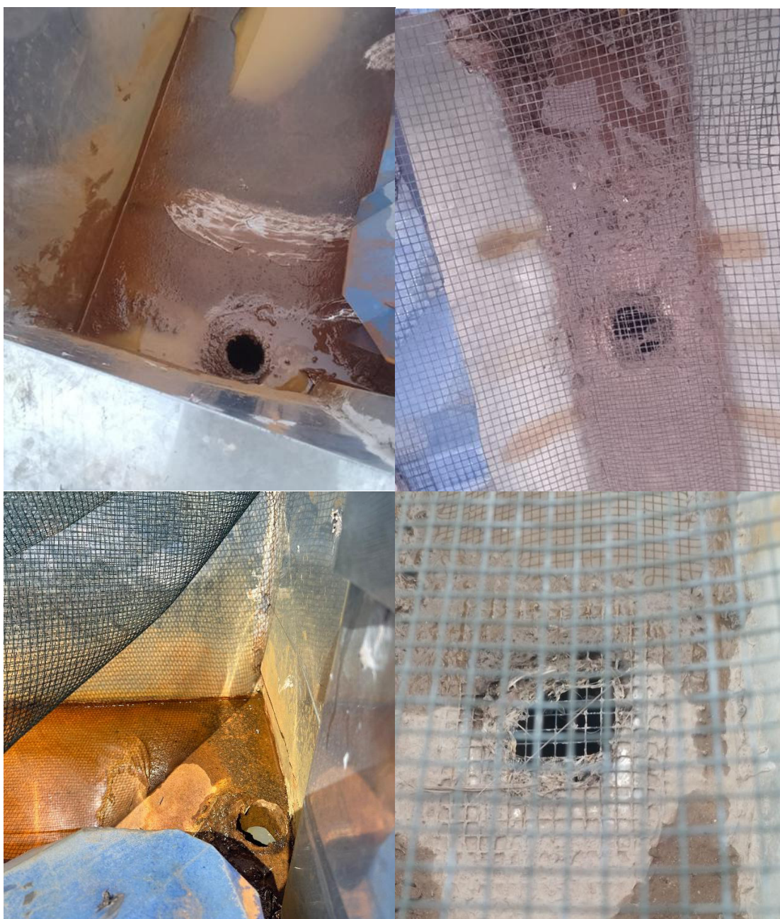
Figura 3 Estado de los puntos de descarga
