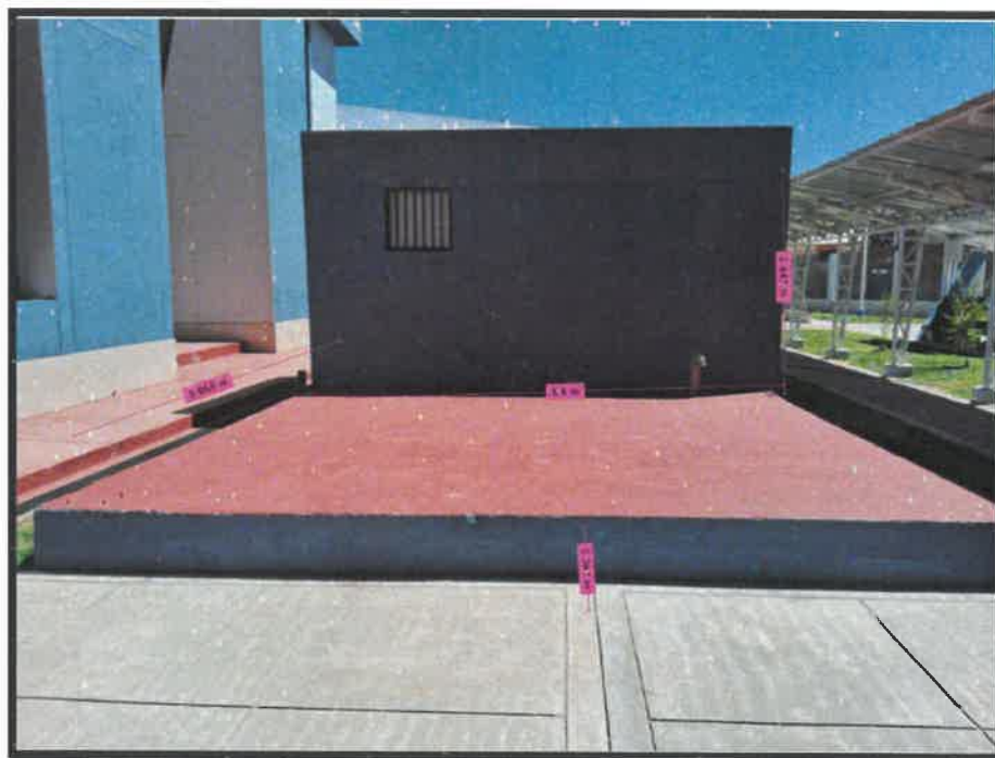
Medidas obtenidas en trabajo de campo para adecuación de almacén.
