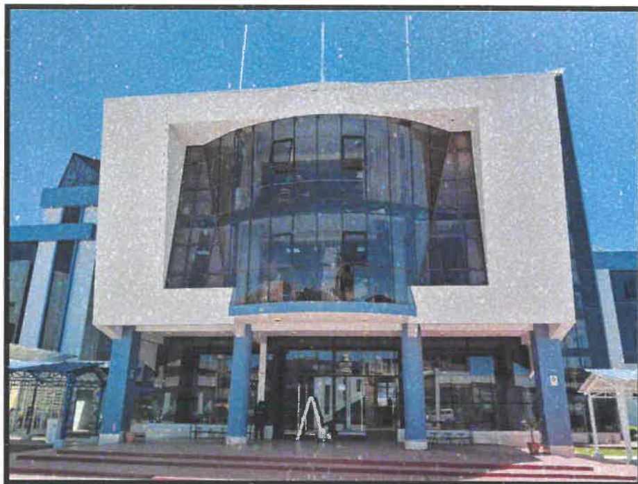
Vista de la fachada principal del pabellón de aulas generales.
