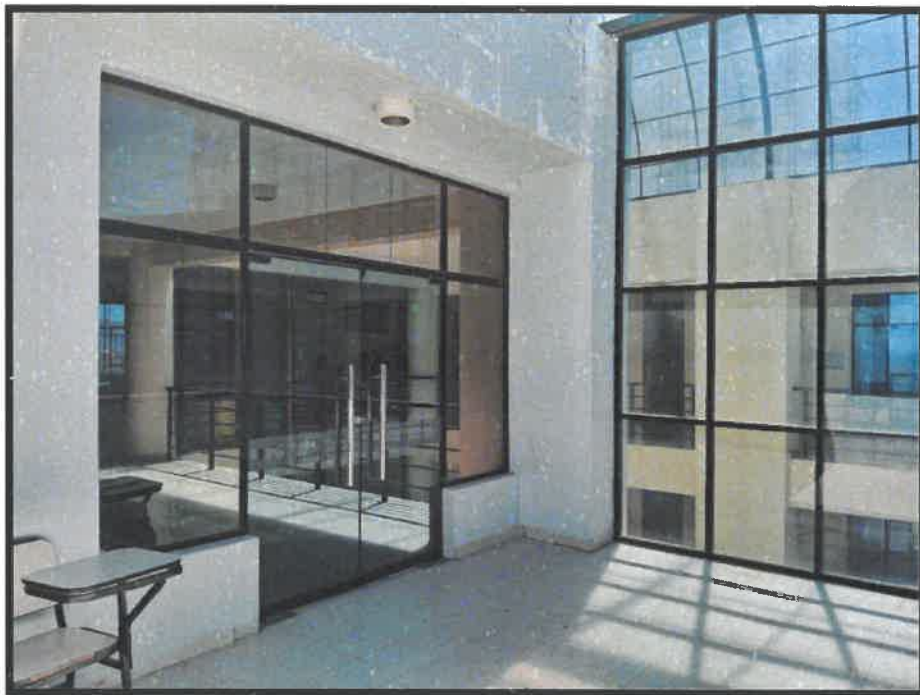
Vista interior donde se adecuará una oficina administrativa.
