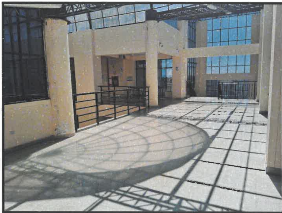
Vista interior del pabellón de aulas generales – cuarto piso.
