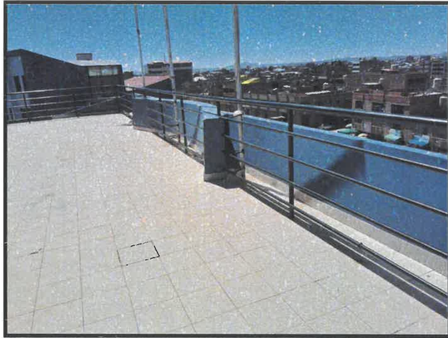
Vista de la terraza del tercer nivel.
