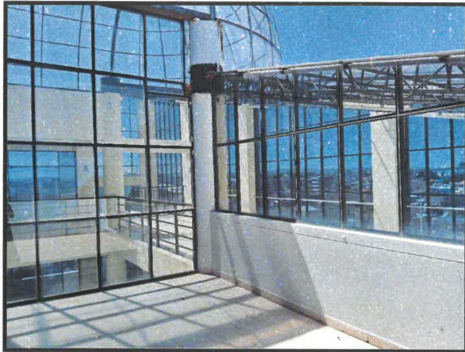
Vista de cobertura donde se adecuará una oficina administrativa.
